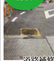
道路補修 千代田駅前踏切
